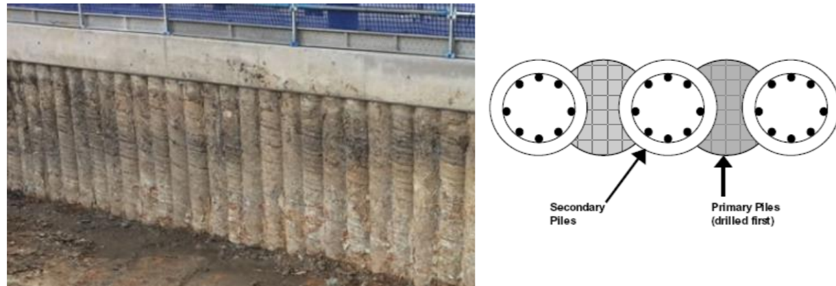
Joonis 17. Vaiadest seinte konstruktsiooni lahendus
